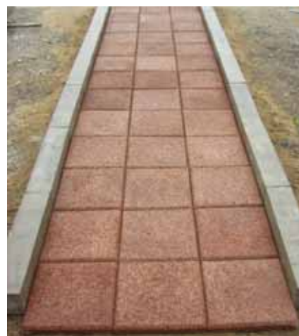
施工例(色はNO.610)
