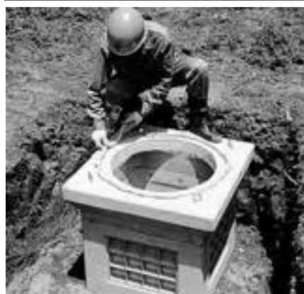
④ B2据付・CR用WSボンド敷
