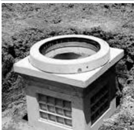
⑤ CR据付WSボンド敷
