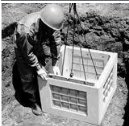
② B1部材据付・レベル測定
