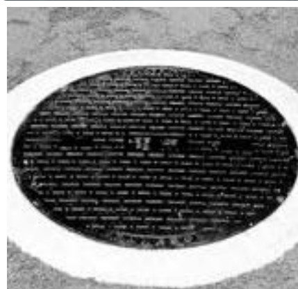
⑥ 据付完了
